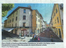
Une opération de renforcement des propriétaires de biens dégradés, dans le quartier de la Gare à Chambéry.
