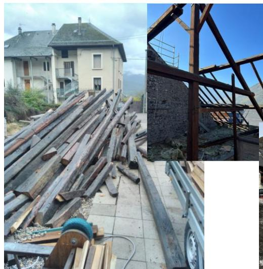
La dépose soignée de la charpente par un professionnel a permis de récupérer 30 m<sup>3</sup> de bois de charpente dans le cadre du dispositif mis en œuvre par l'EPFL pour favoriser l'économie circulaire.
